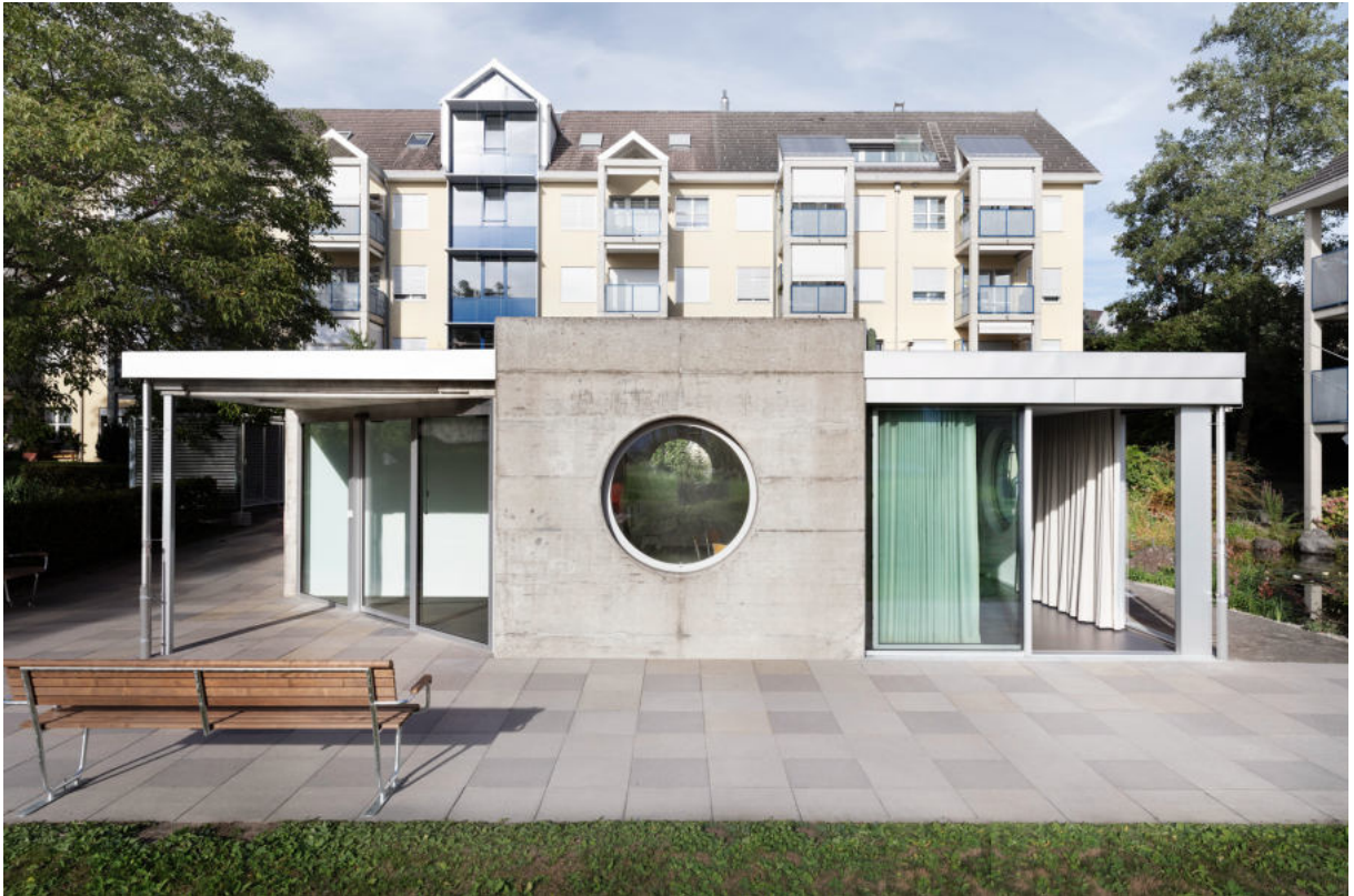
Umbau Pavillon Genossenschaft Sonnenbühl 2022
